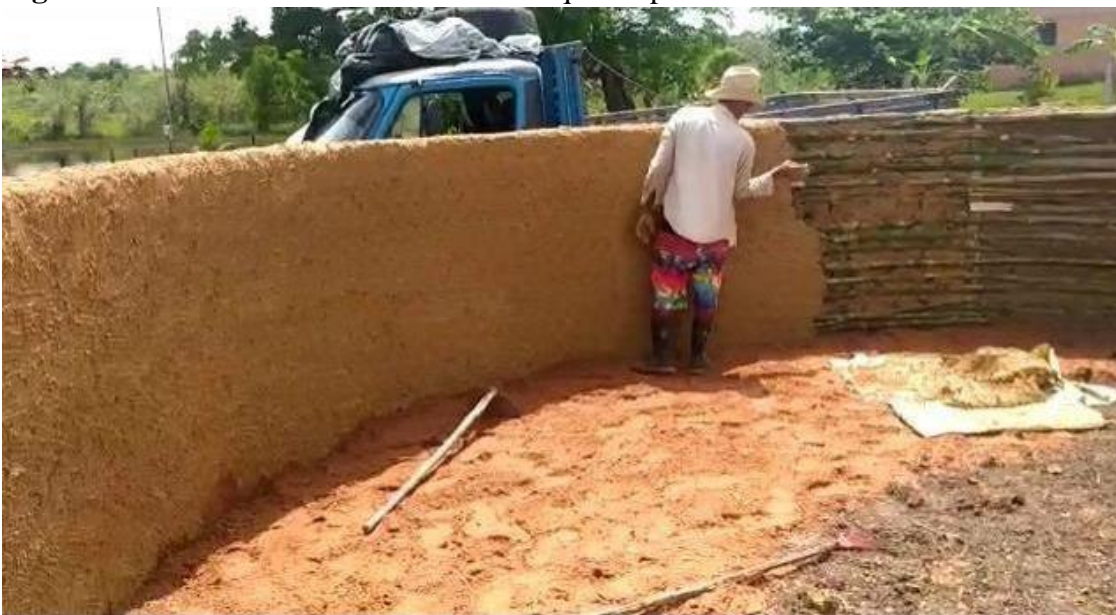
Figura 06 - Processo de acabamento do tanque suspenso.
